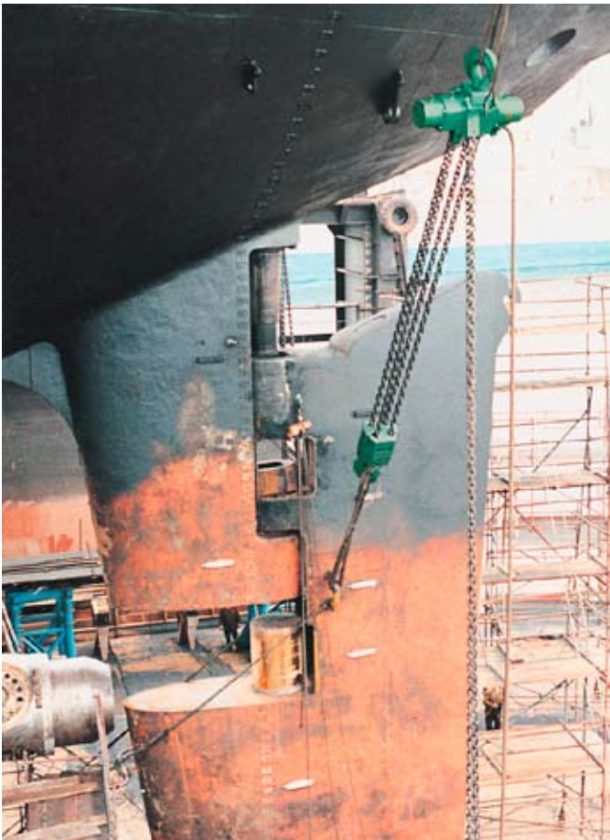
Exakte Positionierung eines Ruderblattes mit zwei JDN-Druckluft-Hebezeugen Profi 100 TI, Tragfähigkeit jeweils 100 t
