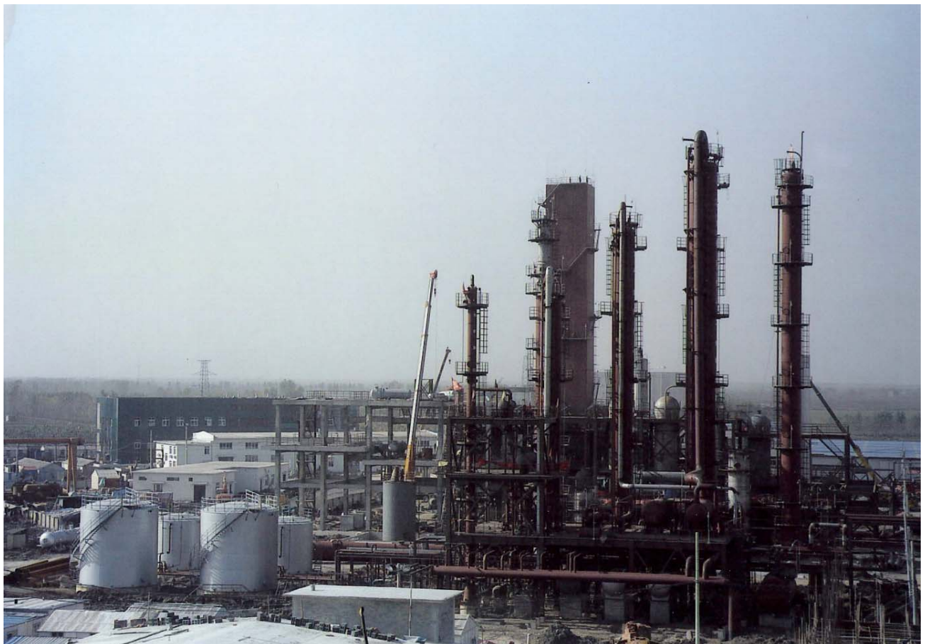
Wiederaufbau der ehemaligen Dortmunder "Kokerei Kaiserstuhl" nahe Zaozhuang, Provinz Shandong
