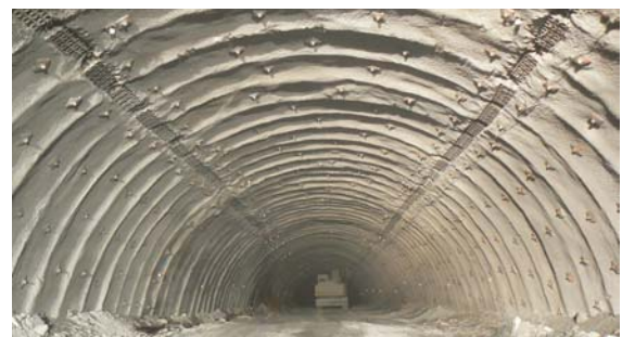
Stauchelement (Foto © ARGE Tauerntunnel)
