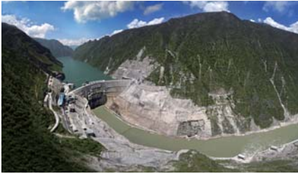
左：拥有 305 米世界最高拱坝的水电站——雅砻江锦屏一级水电站 中上：“发电—海水淡化—浓海水制盐—土地节约整理—废弃物资源化再利用”的“五位一体”循环经济项目——天津国投津能发电有限公司 中下：国投石嘴山光伏发电有限公司 右：国投第一个风力发电项目公司——国投白银风电有限公司
