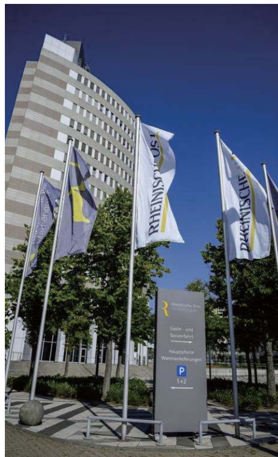
Gebäude Rheinische Post auf der Zülpicher Strasse
