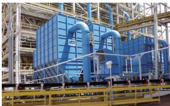
Installierte Deichmann Schlauchfilteranlagen für die Entstaubung einer Eisenerz-Separation in Mauretanien
