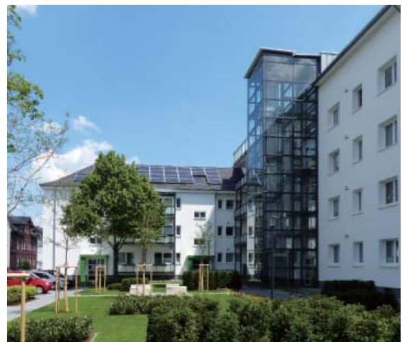
Innovative Sanierung in Siegen: Die vorgestellten verglasten Aufzugstürme prägen zusammen mit den Photovoltaikanlagen das moderne Bild der Siedlung in Siegen
