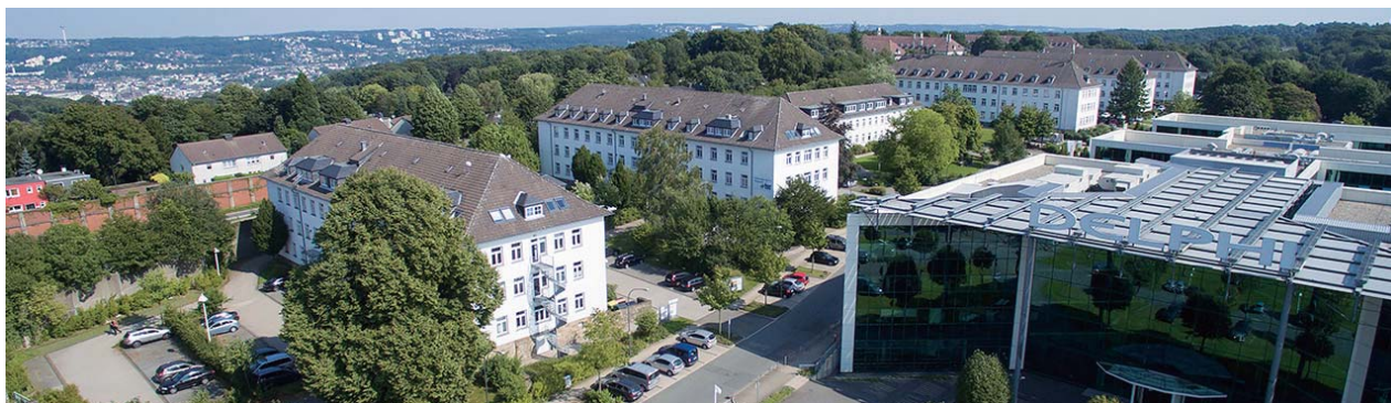
W-Tec GmbH Gebäude
