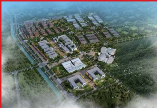
中德新材料产业园
