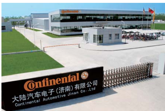
济南高新区大陆电子厂房
